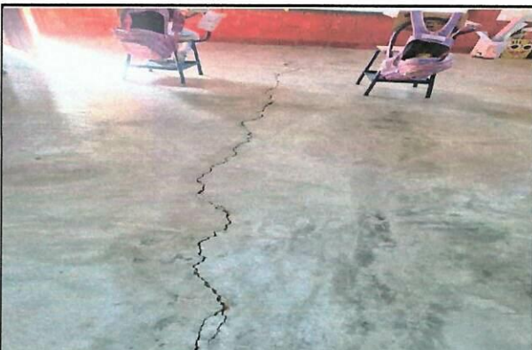
reparación de piso
