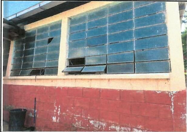
reparacion de ventanas y balcones
